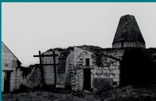
Moulin du Vigneau dégradé ©Archives du moulin du Vigneau
