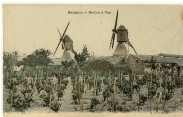
Saumur-moulin à vent ©Archive municipales de Saumur
