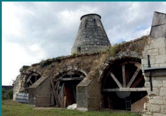
Caves du moulin du Vigneau © CRVAH Saumur2021
