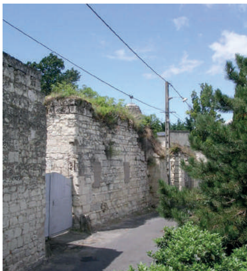
Vestiges de la masse du Moulin de la Galère et à l'arrière plan le massereau du Moulin Godet ©CRVAH Saumur 2021
