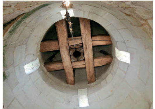
Moulin du Vigneau vue sous le massereau ©CRVAH Saumur 2021
