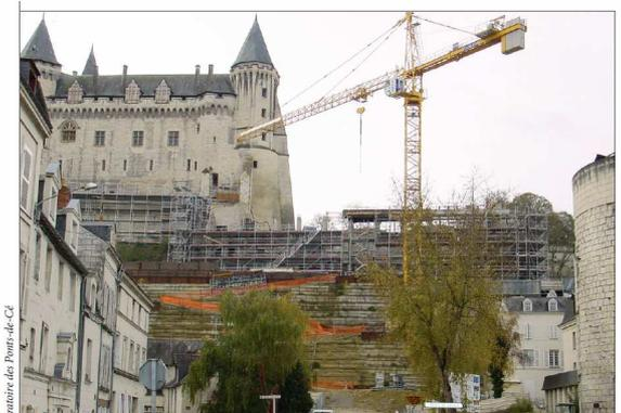
Château de Saumur : travaux effectués suite à l'effondrement des remparts en avril 2001. Source : Laboratoire des Ponts et Chaussées.
