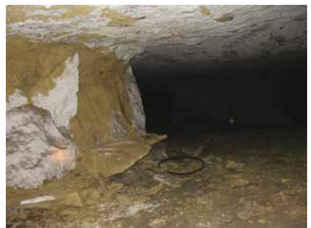
Pilier soutenant une voûte d'une ancienne carrière en cours de dégradation.
