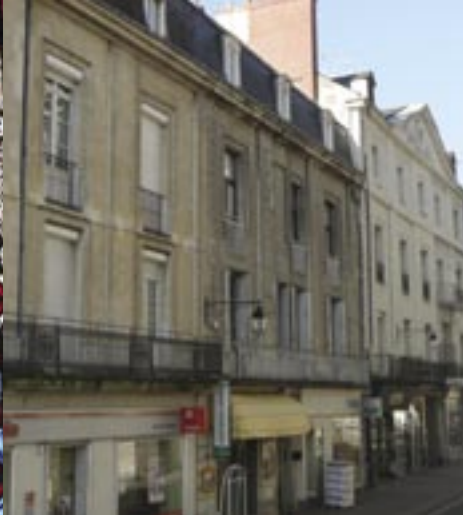
Alignement de façades du 18 e siècle rue Molière.
